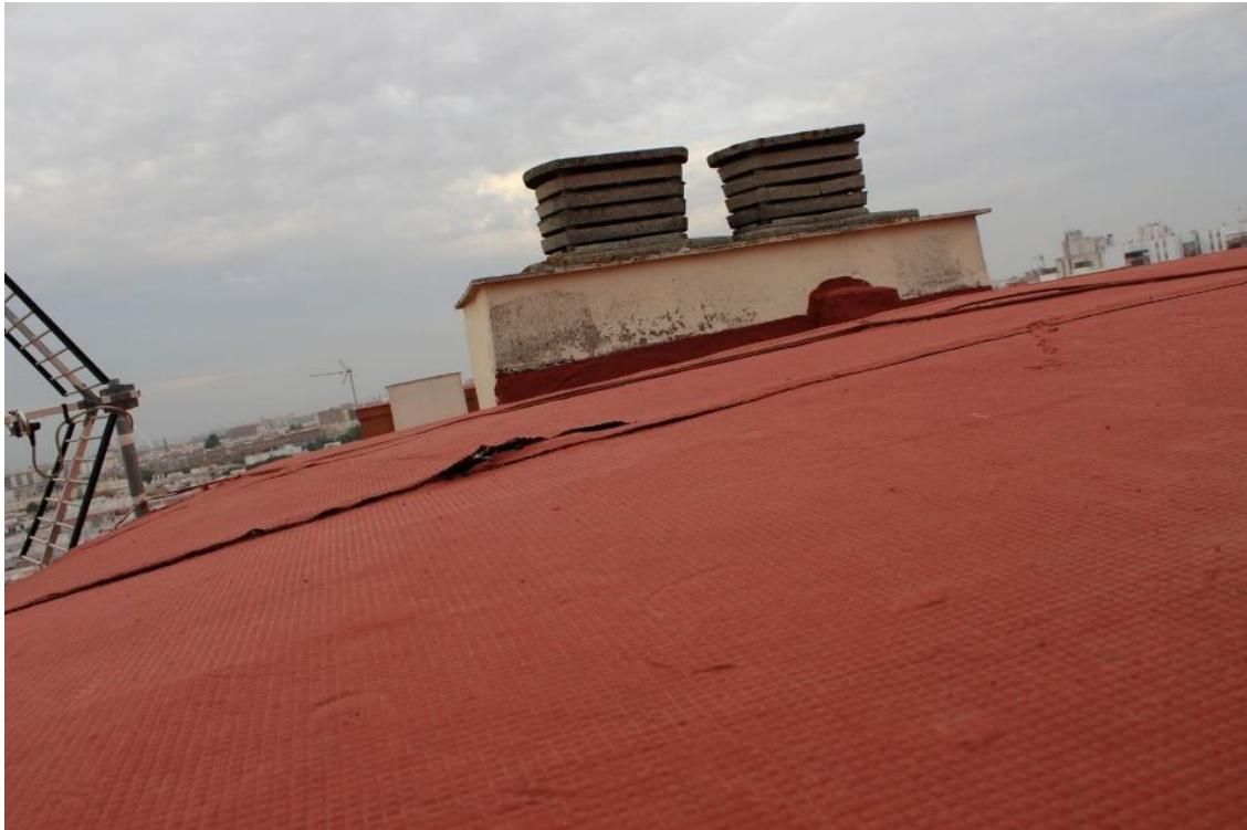
Fig. 21. Fotografía de la cubierta sobre el castillete de acceso a la cubierta del bloque 6, situado en la plaza de Riofrío. Fotografía tomada el 28 de noviembre de 2017.
