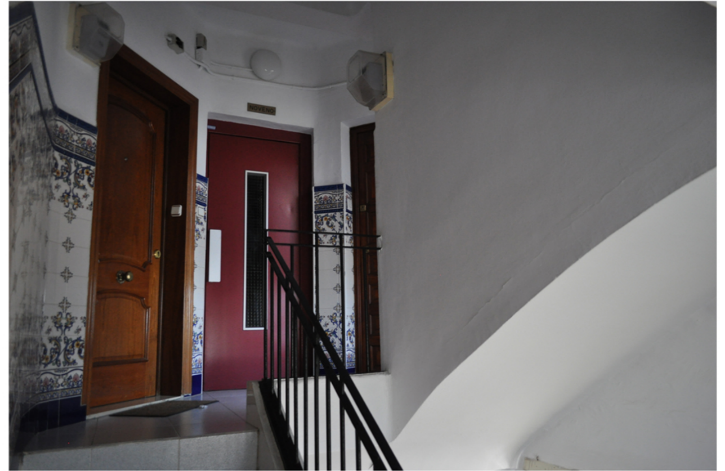
Imagen de lesión: 3.02 D Fisura_2
