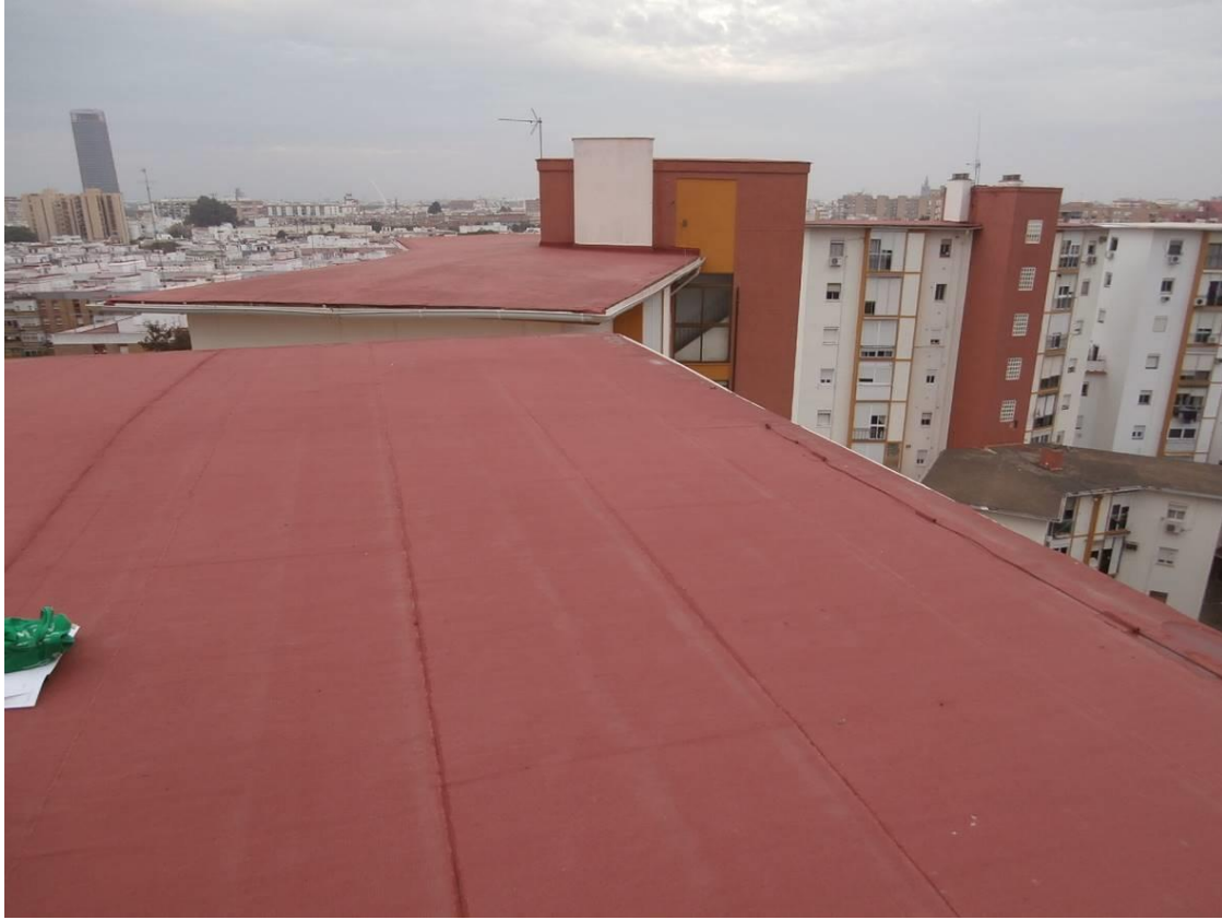
Fig. 53. Fotografía del estado actual de la cubierta del bloque 6.
