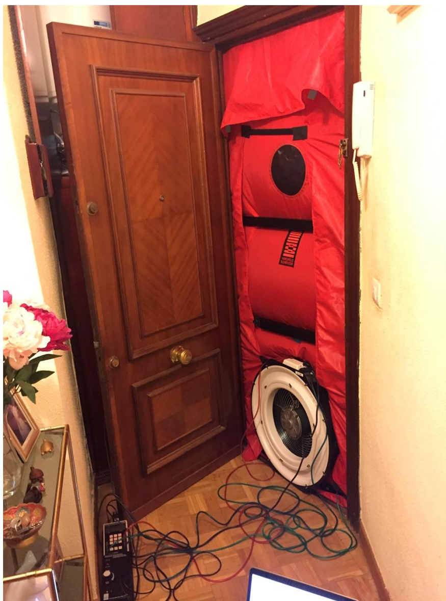
Fig. 49. Instalación del equipo Blower Door para el ensayo de permeabilidad al aire
