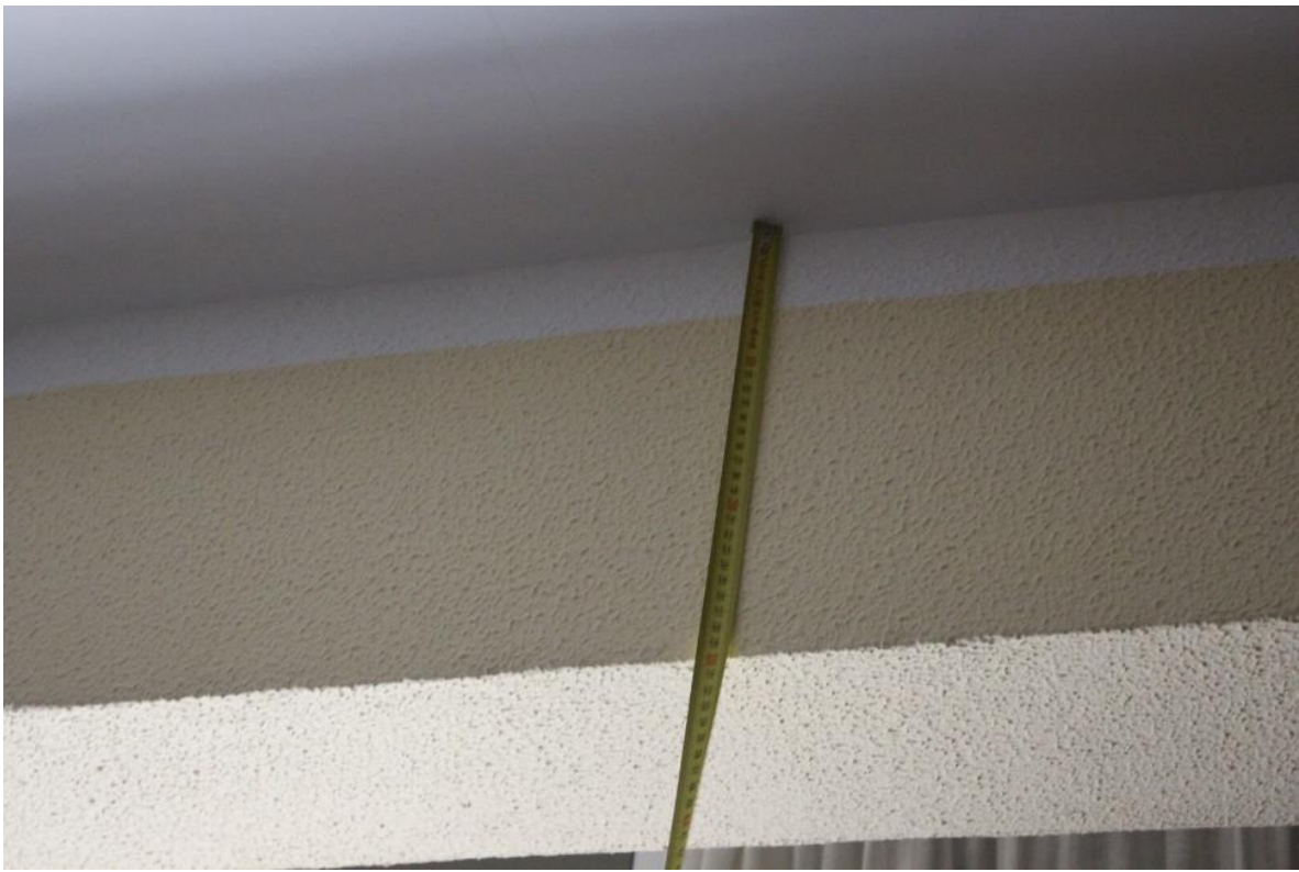
Fig. 23. Fotografía de medición del descuelgue de una viga en la sala de estar del piso 4ºA del bloque 6 situado en la plaza de Riofrío. Más allá de esta viga se encontraría el balcón según proyecto original, hoy día cerrado de acuerdo a las especificaciones en sección constructiva recogidas en el anejo gráfico (del grupo de ANEJOS B). Fotografía tomada el 28 de noviembre de 2017.
