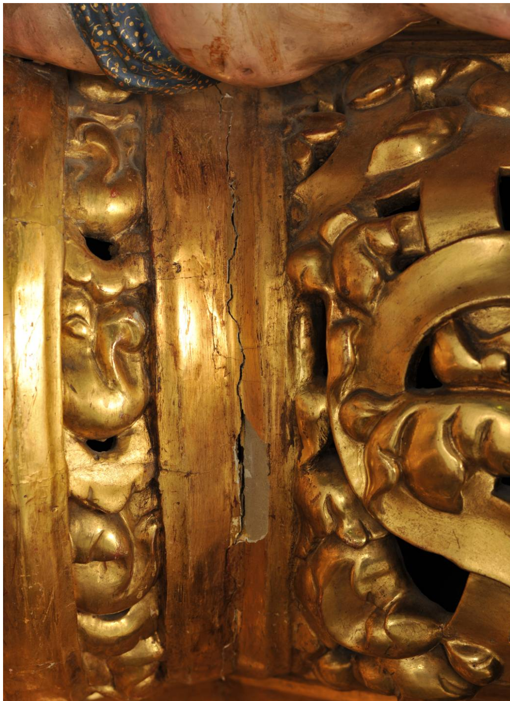
Fisuras. Pérdidas de adhesión en el estrato polícromo
