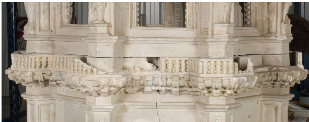
Balaustrada externa que rodea el perímetro de la maqueta. Se ha añadido posteriormente. Los clavos de hierro ayudaban a anclarla a la cornisa.
