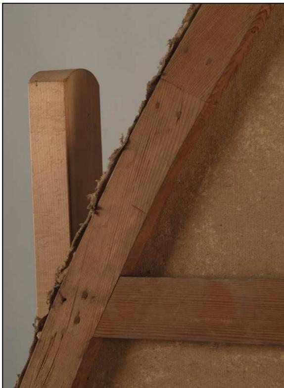
Detalle del ensamble del travesaño de caja y espiga con escopladura abierta, espigas, y acoplamiento del larguero curvo con lengüeta.
