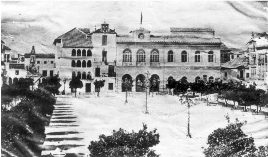
FIG. 7. Proceso de construcción de la fachada del Ayuntamiento, con los antiguos inmuebles propiedad del Marqués de Peñaflor y Dña. María Baillo aun conservados, 1887 ca. Foto: Juan Méndez Varo.
