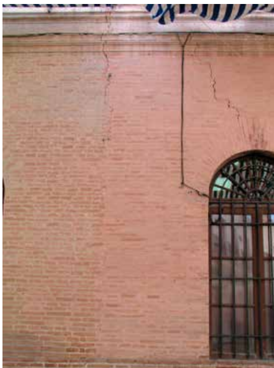
FIG. 13. Encuentro en fachada de calle del Conde de las obras realizadas en la 2ª y 4ª Sección.
