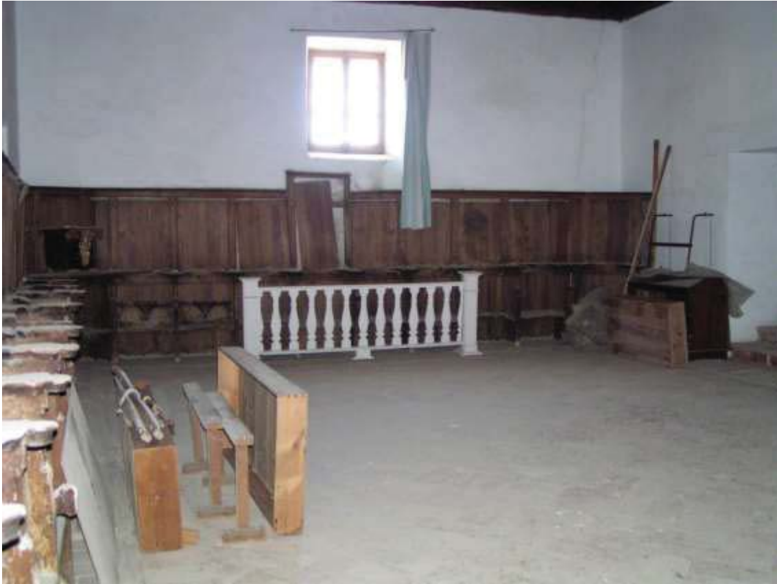
Fig. 3. Sillería del coro alto del convento de la Concepción de Carmona, proceso de deterioro muy avanzado por el abandono paulatino. (AMP).
