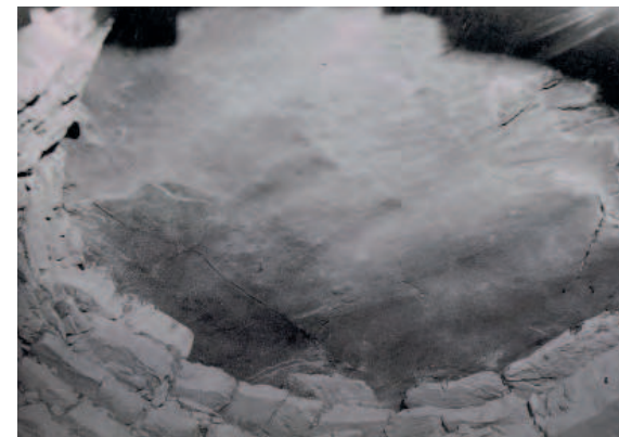
Losa de cierre de la cúpula de El Romeral. Estado posterior a la intervención de 1940.
