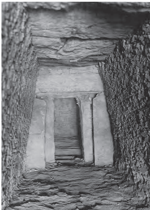
Puerta de acceso a la cámara de El Romeral tras su restauración en 1940.
