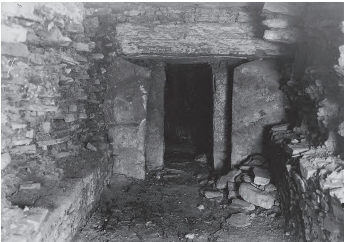
Estado en 1938 del corredor de El Romeral y de la puerta de acceso a la cámara.
