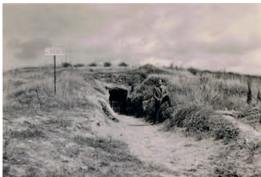
Giménez Reyna en el acceso al tholos de El Romeral después de la intervención de 1940.
