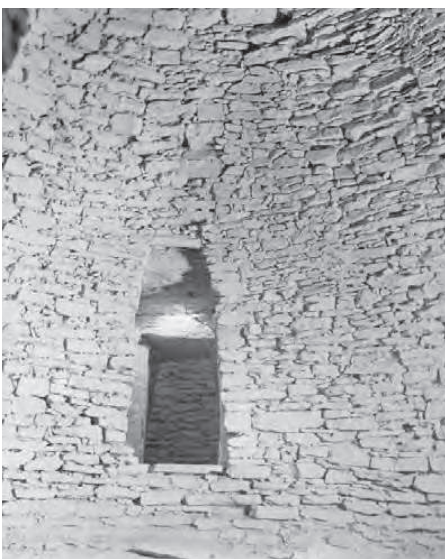
Cámara y puerta de la camarita en el tholos de El Romeral. Fuente: A.H.M.A. Fondo Fotográfico Velasco.
