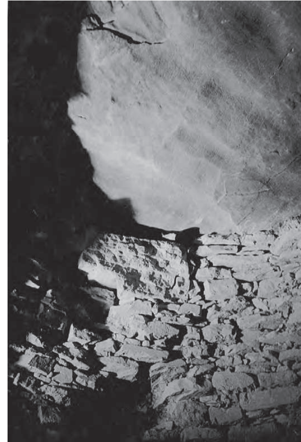
Detalle de la cúpula del tholos de El Romeral, antes de la intervención de 1940.
