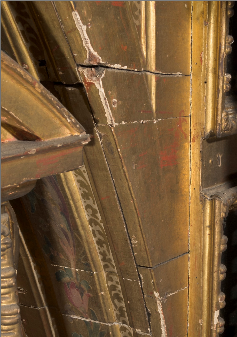
DESAJUSTES Y PÉRDIDAS DE PIEZAS CONSTITUTIVAS (DETALLES)
