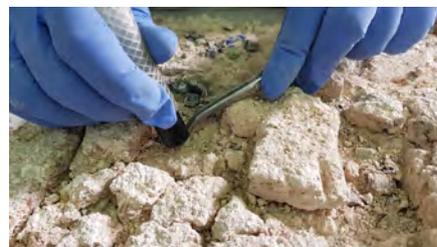
Proceso de aspiración puntual y colocación de teselas sueltas en sus sedes originales
