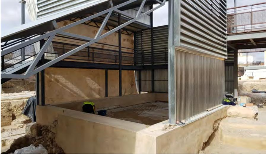
Estructura metálica construida en la ubicación original para la protección del mosaico
