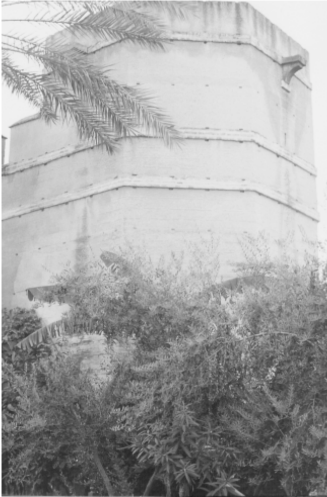
LAM. I. Torre albarrana de la calle Merinos.
