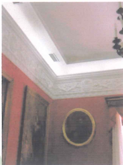
SISTEMAS DE ILUMINACIÓN
