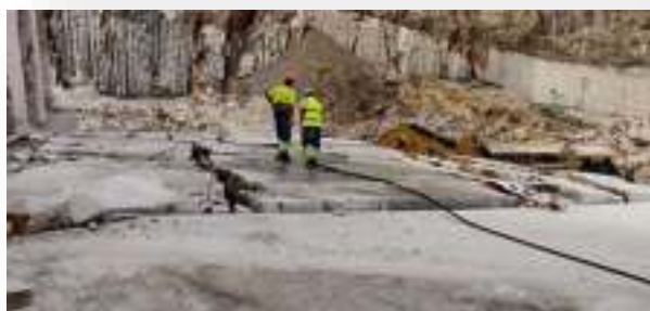
Ilustración 35: Canteros regando la superficie para detectar micro fisuras
