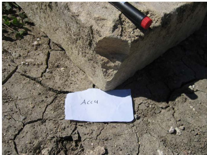
Fig.4. Punto extracción de la muestra ACC-4 de (ladrillo Domus)
