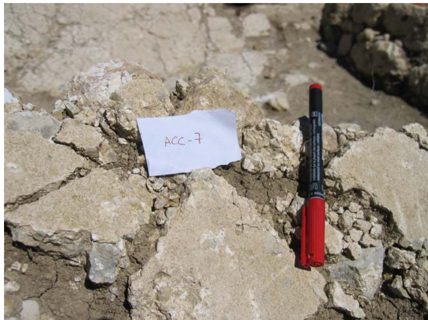
Fig. 6. Punto extracción de la muestra ACC-7. Hormigón cal
