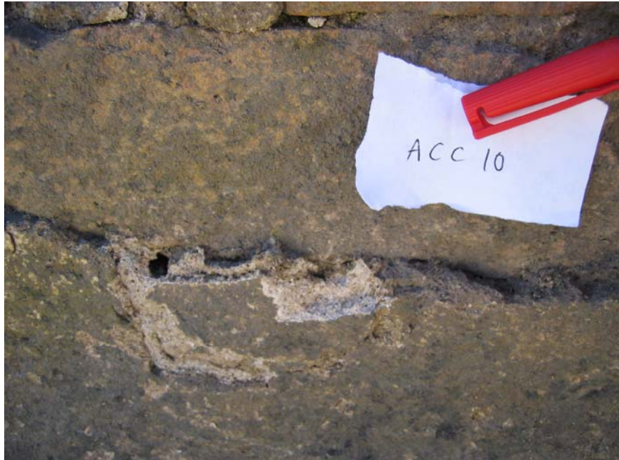
Fig. 9 Zona toma de la muestra ACC-10. Revestimientos Termas
