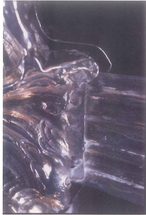
Detalle de uno de los elementos colocado en una antigua intervención para sujetar el haz de luz al alma interna de hierro
