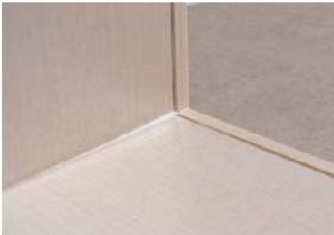
Foto nº 4 vista de cerca de la aplicación del material barrera
