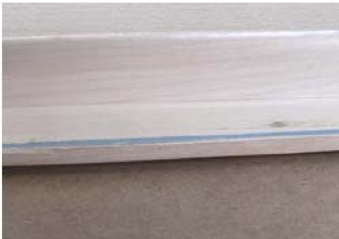
Foto nº 3 Macro fotografía del ángulo interno de la vitrina
