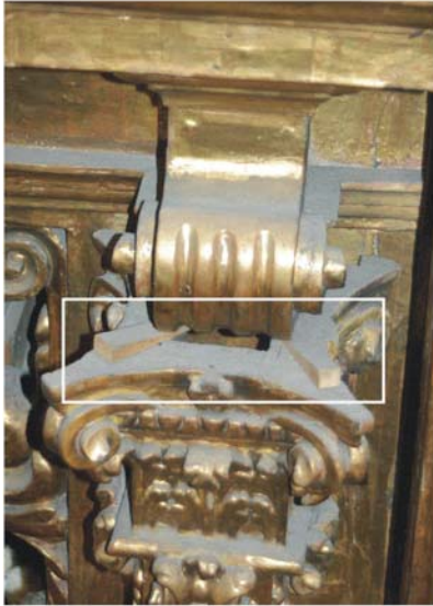
Colocación de calzos en el estípite derecho de la hornacina central.
