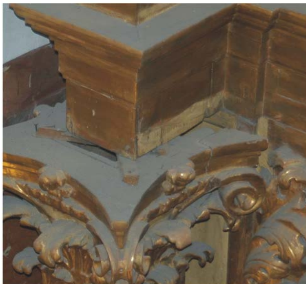
Separaciones de piezas. Fractura de pequeño fragmento. Acumulación de polvo.
