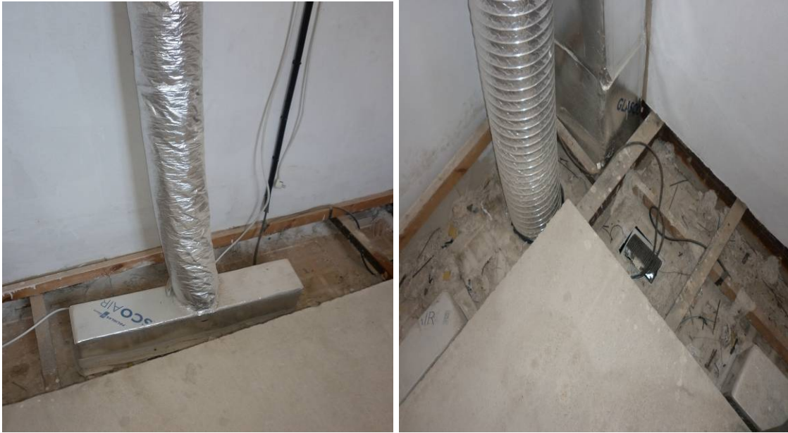
Fotos nº 8-9. Vista de la instalación de impulsión y vista de impulsión y retorno del aire climatizado (Foto Raniero Baglioni).
