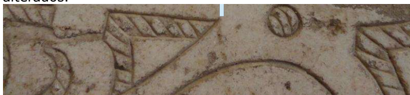
Fig.2.18. Detalle de la zona del escudo donde se manifiesta la alteración, exfoliación y erosión. La flecha azul indica una alteración del mármol que se denomina sacaroidea.
