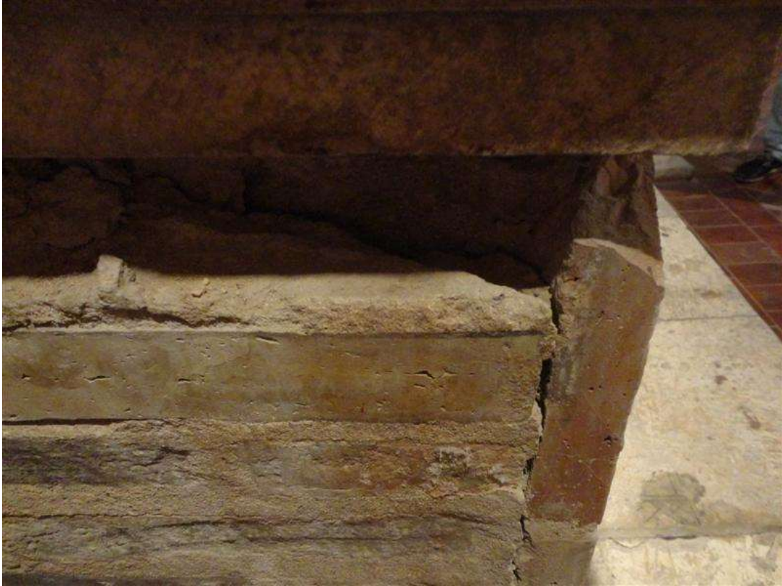
Fig.2.10. Lateral izquierdo. Como está fracturado se ha podido tocar el mortero que hay en el interior.
