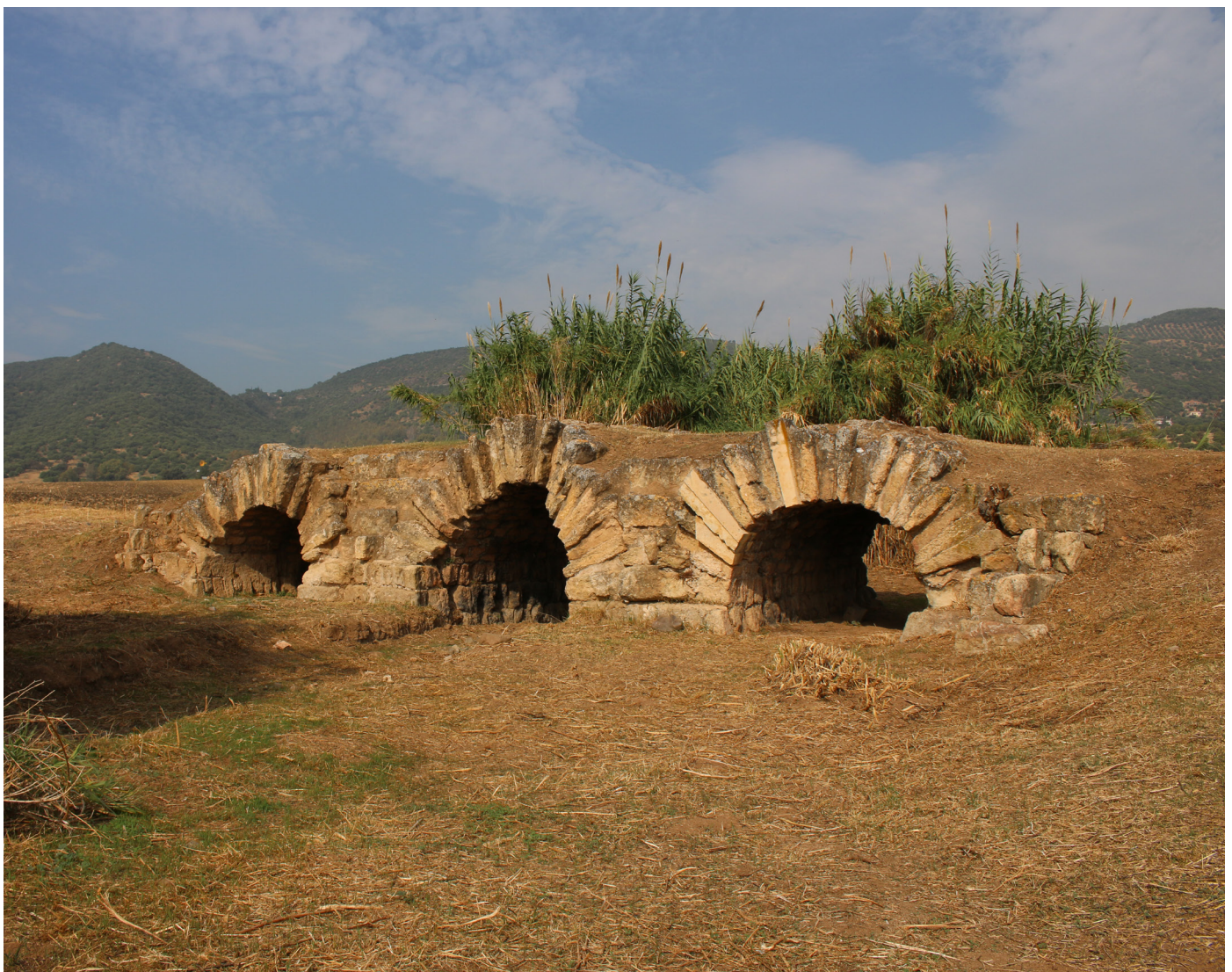
Puente de los Nogales
