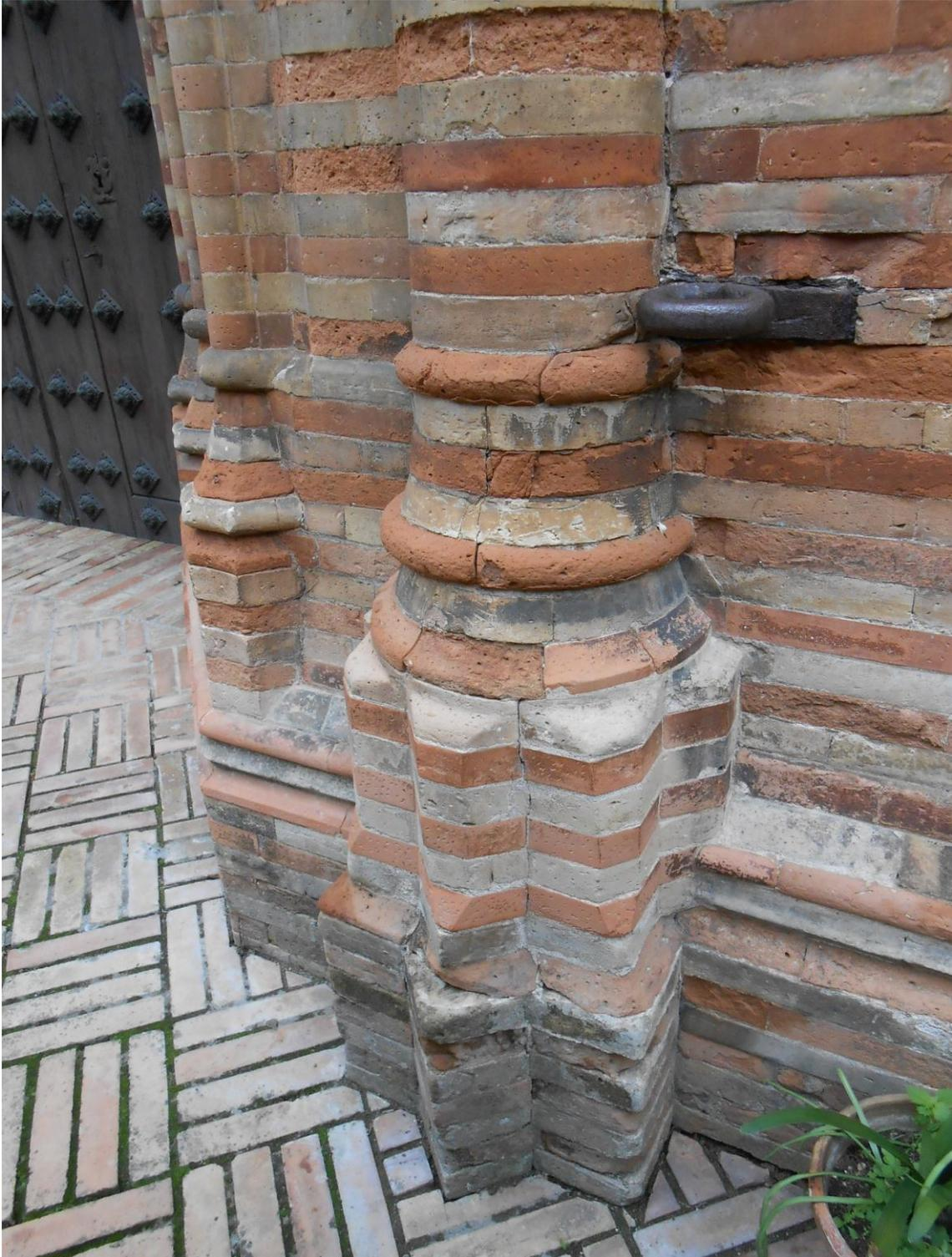
15. Detalle de la fábrica de ladrillo que conforma la portada
