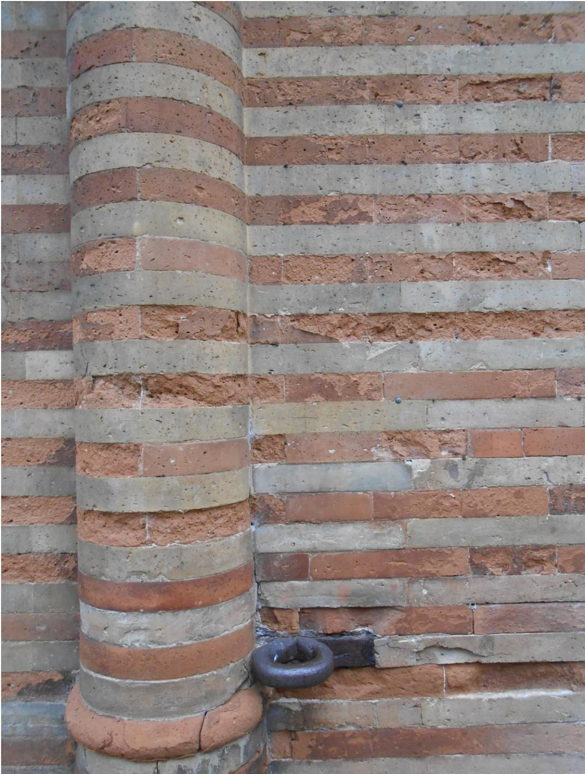
14. Detalle de la fábrica de ladrillo que conforma la portada
