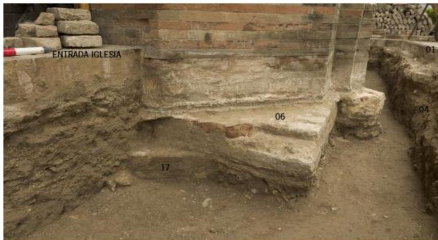
Figura IX.1.19: Detalle en perfil de superposición de las cimentaciones norte (arriba) y sur (abajo) de las portadas de 1504 y de la anterior (Fuente: IAPH)
