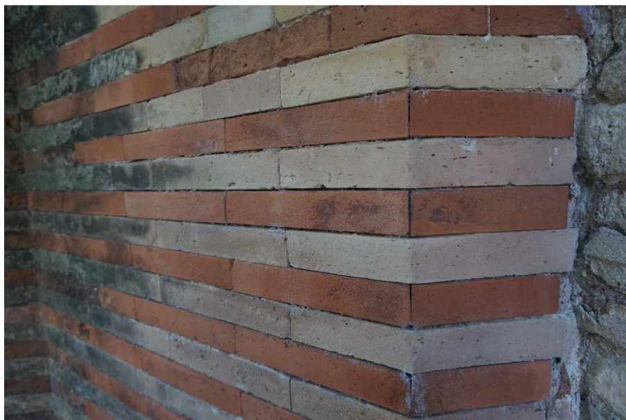
Reposición volumétrica de ladrillos.
