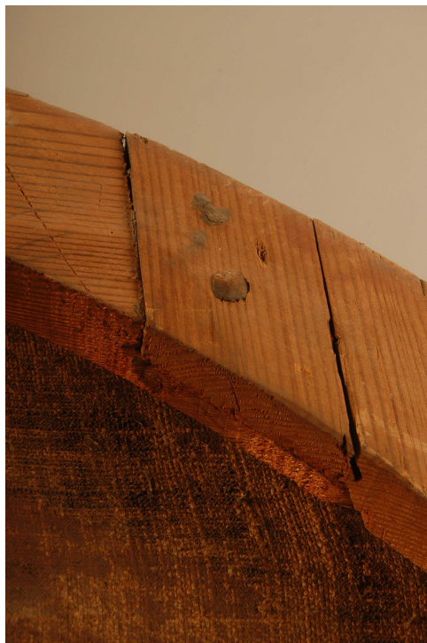
Medio punto del bastidor y detalle del ensamble a media madera izquierdo fragmentado.
