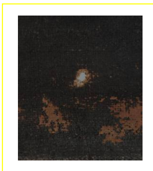
DETALLE DE AGUJERO CON PÉRDIDA DE SOPORTE
