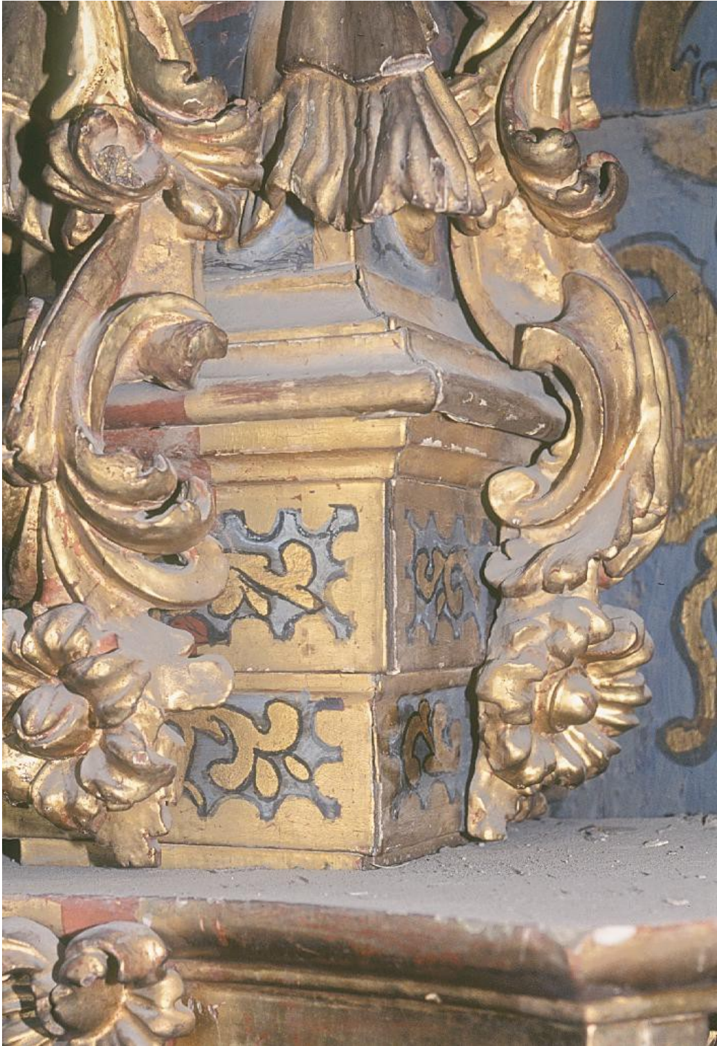
Retablo Mayor: detalle de los desajustes y separación de piezas en las pilastras.
