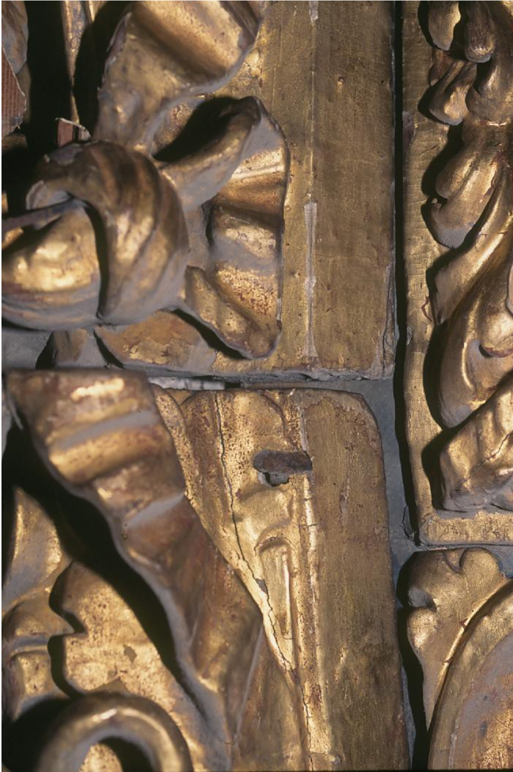
Detalle de las separaciones de piezas y de las fisuras del soporte
