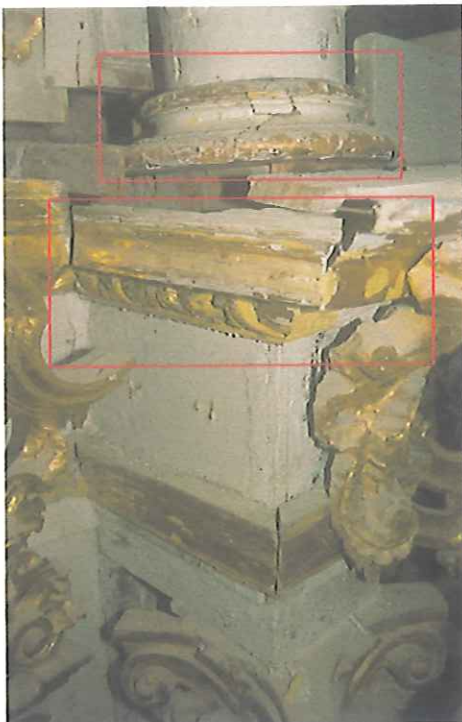
Entablamento 2º cuerpo. Falta de adhesión y pérdidas del dorado. Repintes ocres disimulando las pérdidas.
