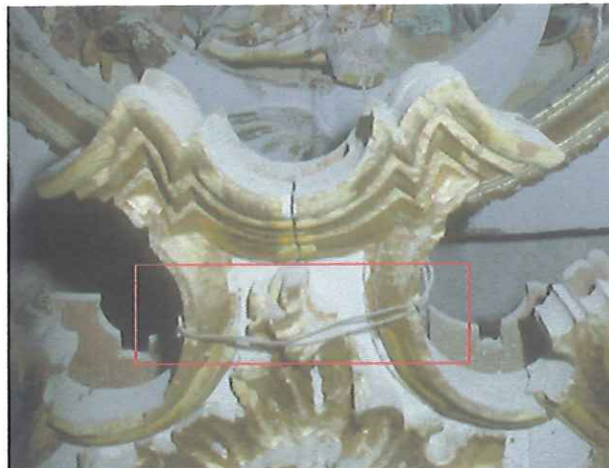
Intervenciones identificables. Colocación de alambres como sistema de sujeción.
