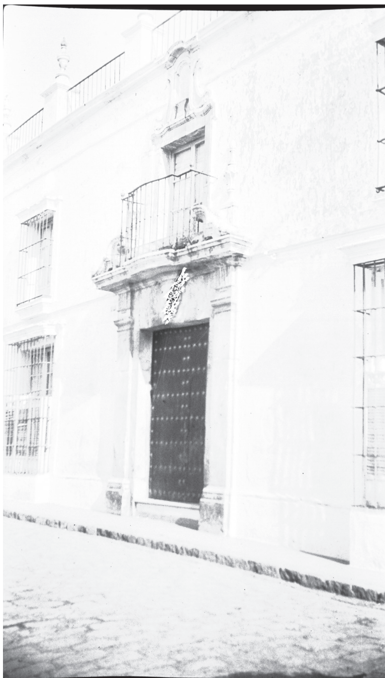
Casa palacio en la calle Largo. Fototeca del Laboratorio de Arte. Universidad de Sevilla. Diego Angulo Íñiguez, 08-05-1927, registro 2-7096
