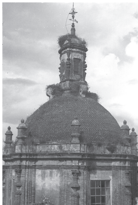
Cúpula y tambor de la iglesia de San Pedro. Fototeca del Laboratorio de Arte. Universidad de Sevilla. Autor y fecha desconocidos, registro 1-22-39
