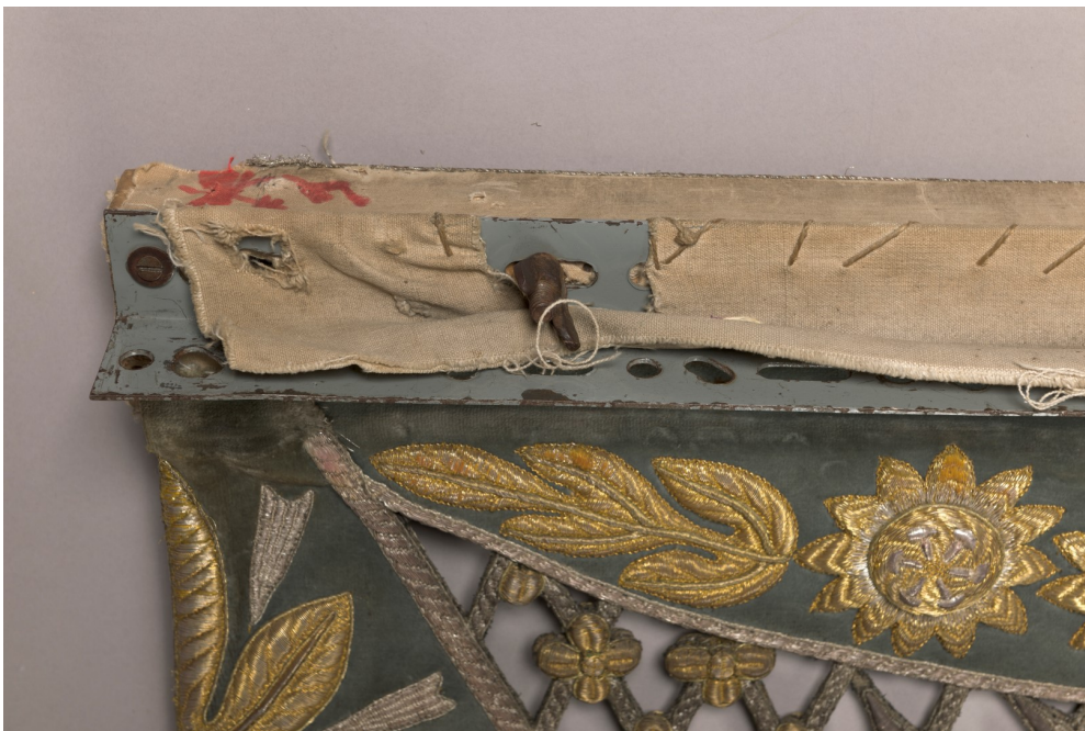
Detalle de la estructura metálica de la cornisa
