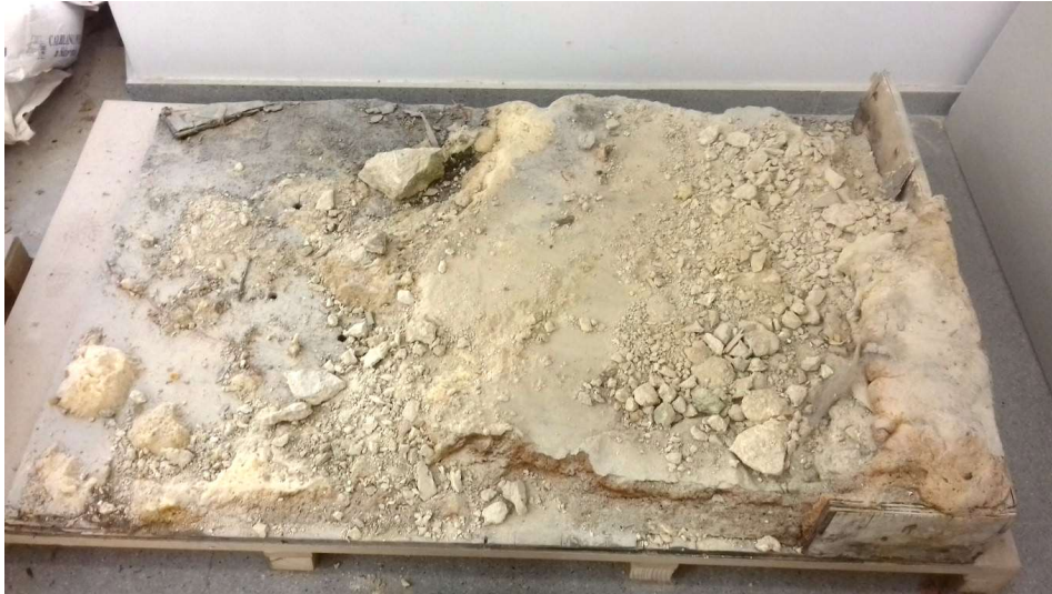
Pieza B5 enmascarada entre restos de mortero, poliuretano y suciedad
