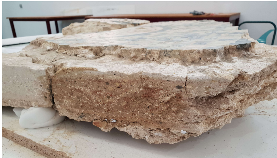
Mortero humedecido para facilitar la observación de las diferentes capas aplicadas
