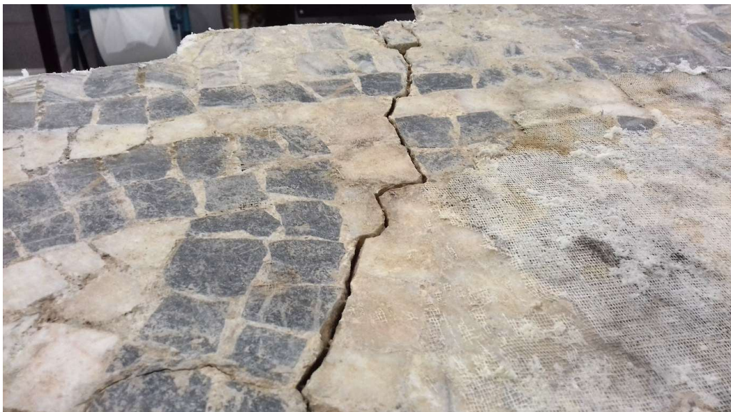
Grieta en anverso
