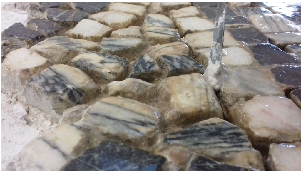
Relleno de grietas con mortero
