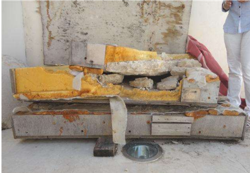
Fragmentos almacenados en cajas superpuestas a la intemperie
