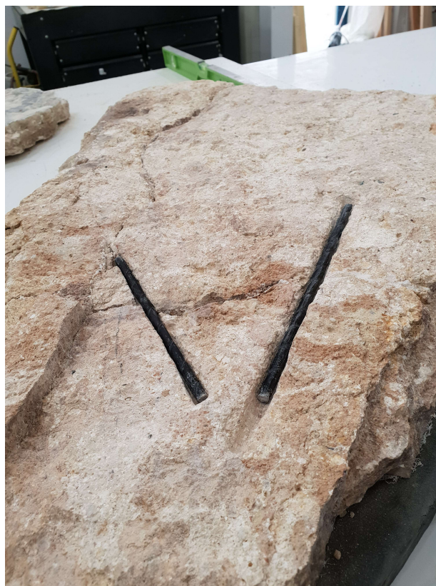
Cajeados en mortero con varillas de fibra de vidrio
