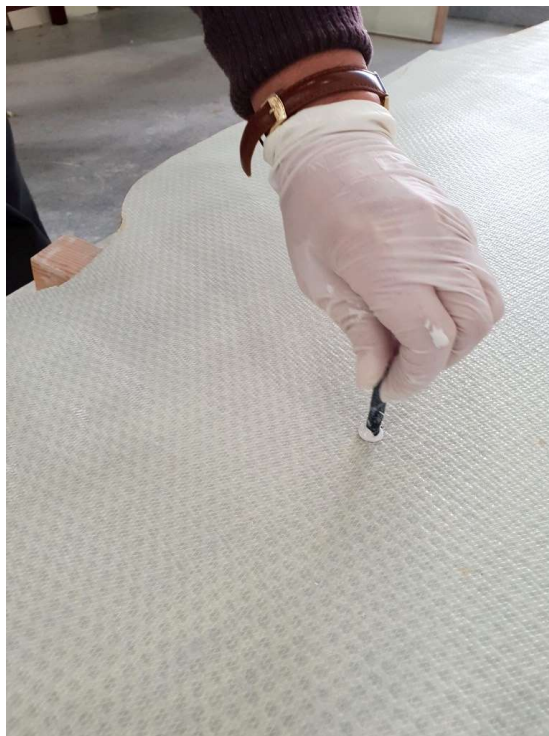
Colocación de espigas con resina epoxi
