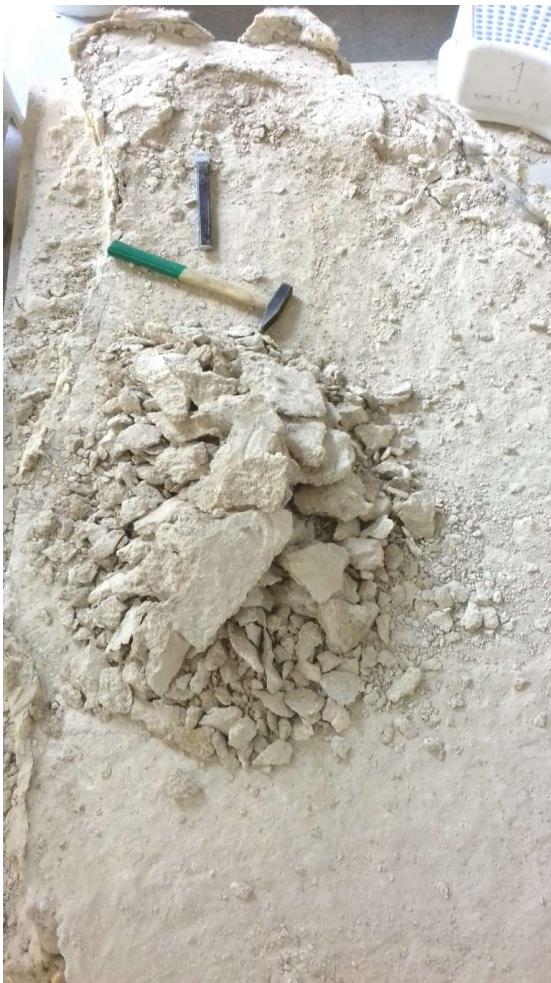
Eliminación de mortero por reverso
