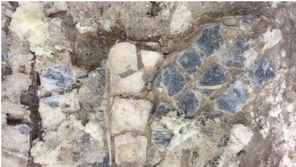
Depósitos de suciedad superficial, restos de gasa y poliuretano
