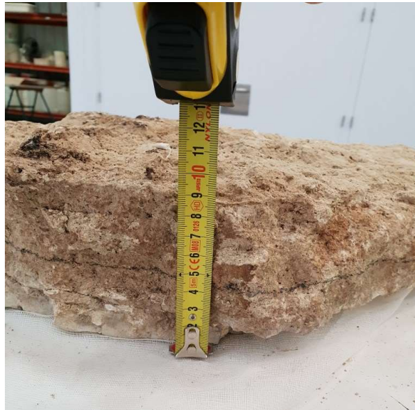
Toma de datos: grosor mortero
