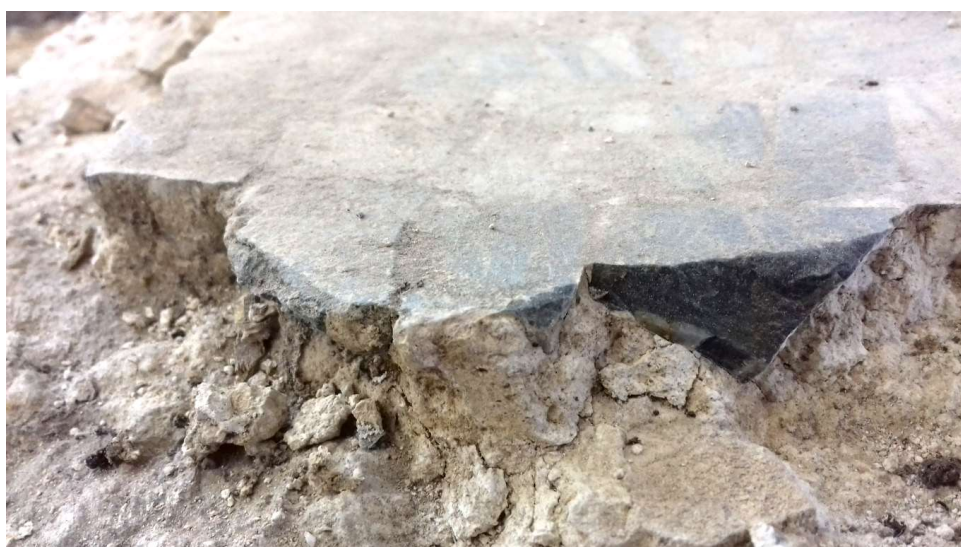
Teselas con pérdida de materia
