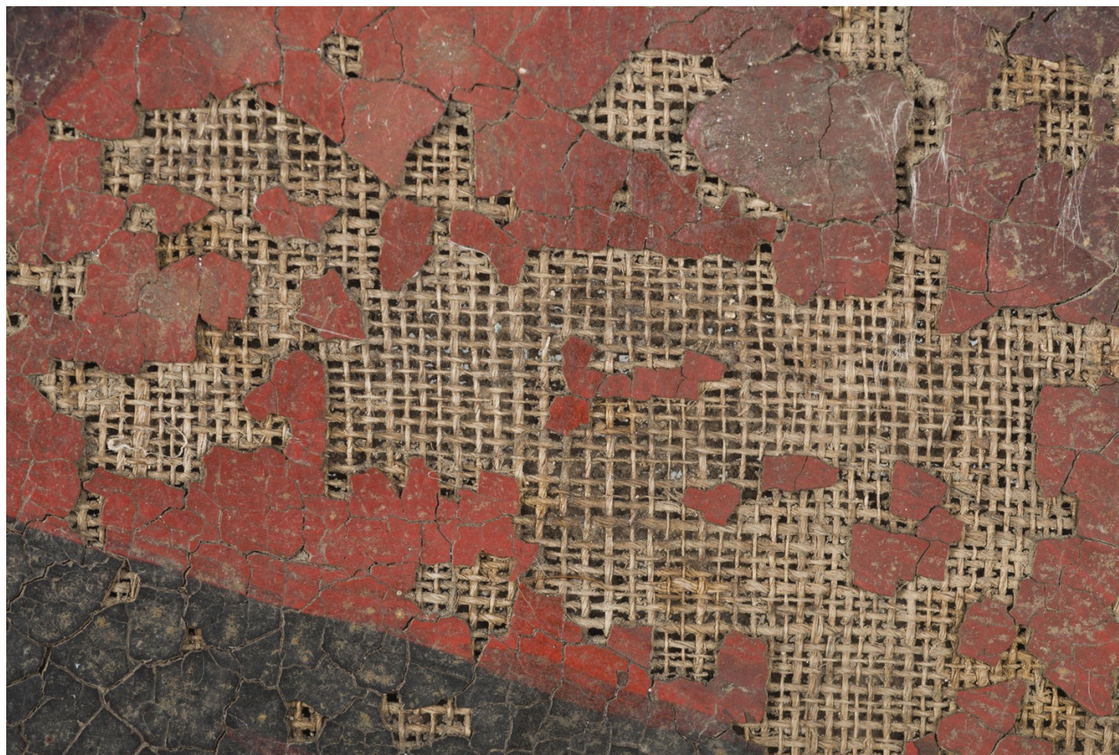
DATOS TÉCNICOS DEL SOPORTE. ANVERSO. CONSTRUCCIÓN INTERNA TIPO TAFETÁN.
