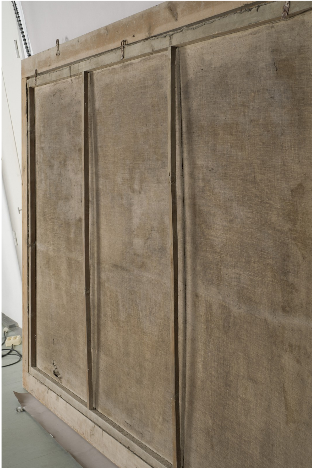
ESTADO DE CONSERVACIÓN DEL BASTIDOR. ALBEO DE LOS TRAVESAÑOS.
