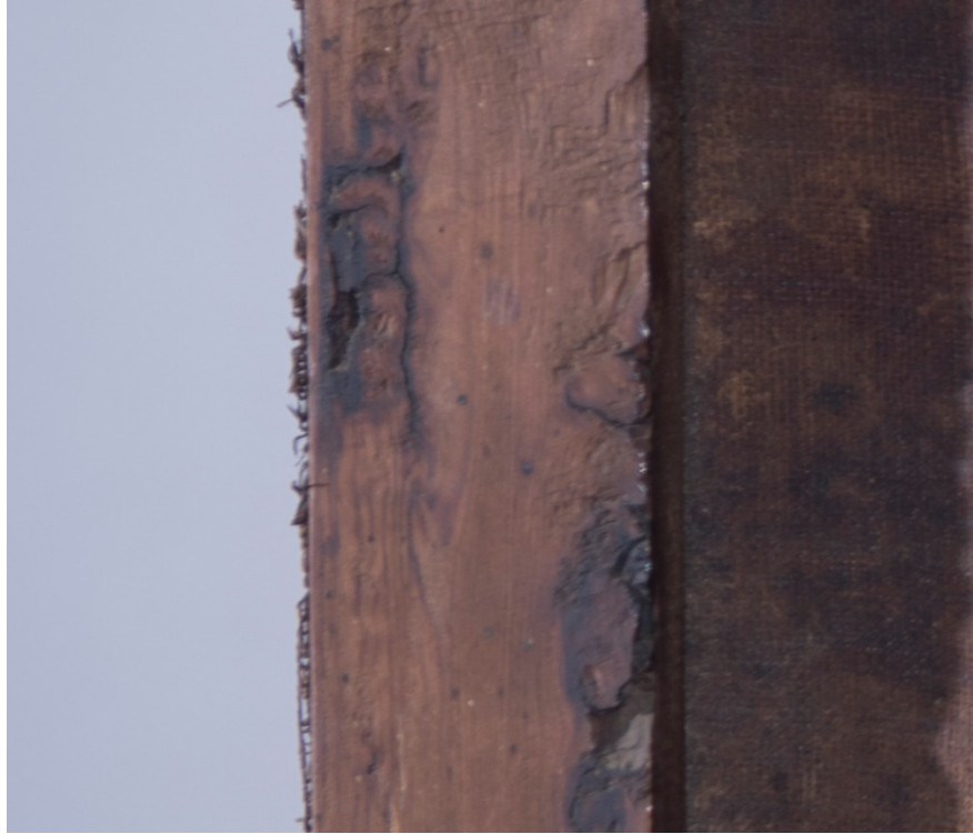
Daños en el bastidor por la presencia de nudos y ciertas exudaciones de la madera
