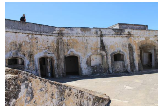
Figura 20.31: deterioro de los edificios interiores del Forte de Graça. Fuente: la autora
