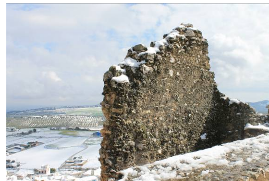
Figura 14.22: Restos de la alcazaba de la Estepa islámica, en el Cerro de San Cristóbal. Al fondo, la campiña sevillana. Fuente: la autora
