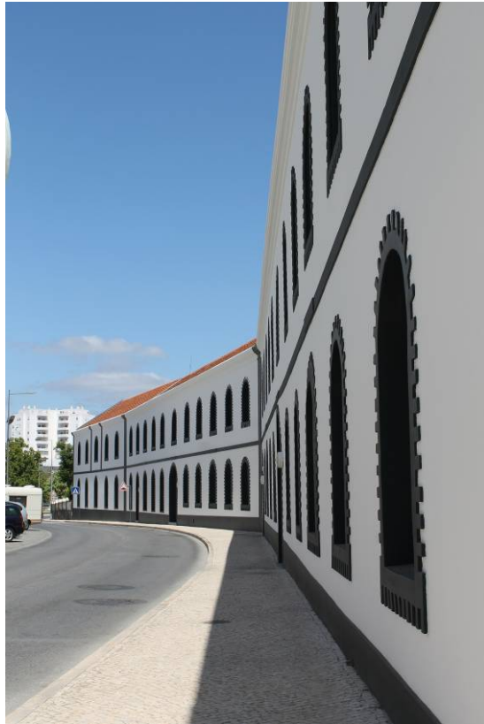
Figura 19.34: Museu de Portimão (antigua Fábrica de Conservas La Rose Feu Hermanos), en su fachada hacia la Rua Dom Carlos I. Fuente: la autora.
