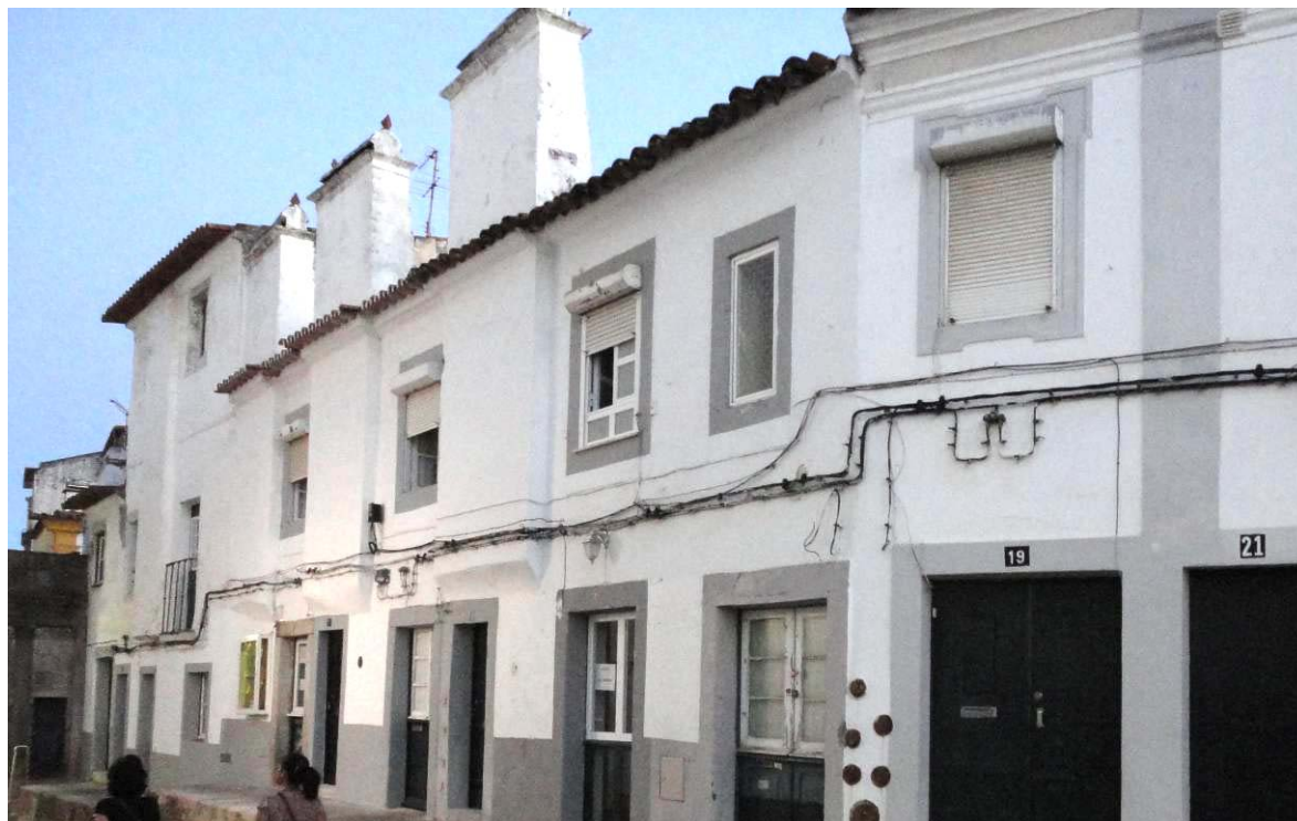
Figura 19.18: Viviendas con cocina en la fachada en Évora. Fuente: Pedro del Espino Gómez.
