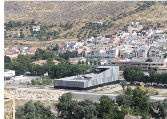
Figura 14.31: Construcción de nuevos servicios en la periferia de Loja (en este caso, en la margen norte del río Genil). Fuente: la autora.
