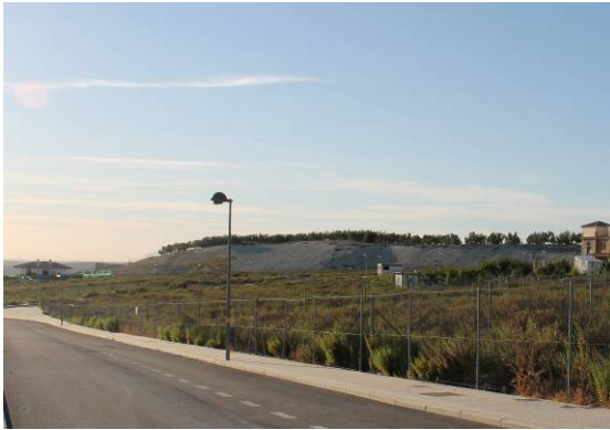
Figura 9.2: Artificialización de terrenos para la construcción de Plan Parcial “El Cahiz”, en Lucena. Desmonte de tierras de olivar con problemas de corrimiento. Fuente: la autora.
