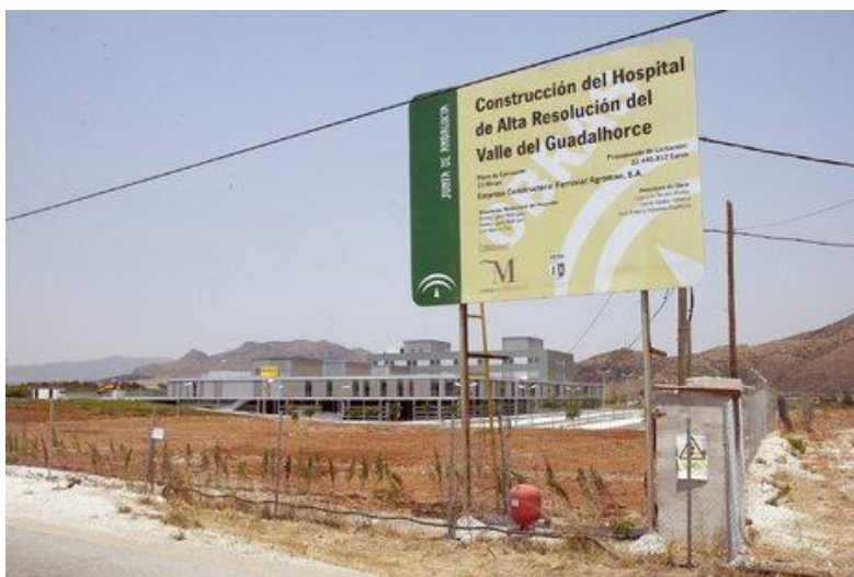
Figura 1.21.: Situación actual del Hospital de Alta Resolución Valle del Guadalhorce.
