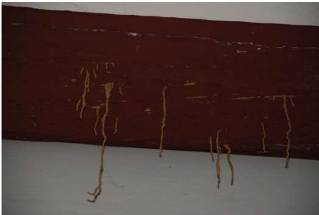
Fig 3. Túneles de progresión colgando de una de las vigas.
