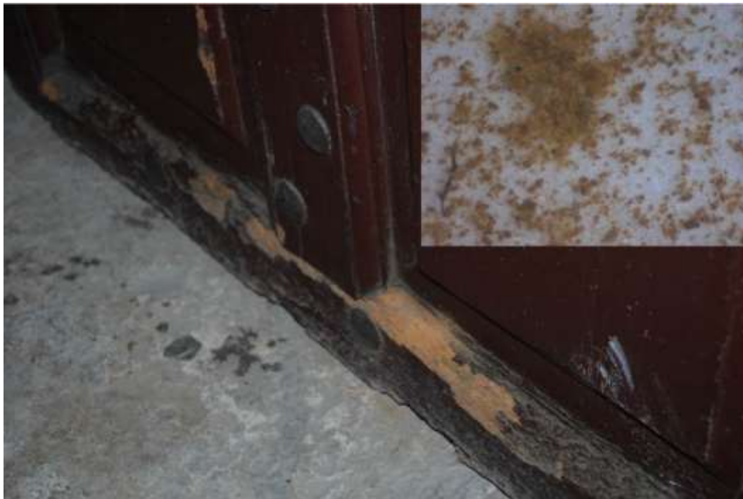
Fig 7. Daños por termitas en la puerta de la sacristía. En el recuadro, arriba a la derecha, una muestra de serrín recogido, a la lupa binocular, 40X.
