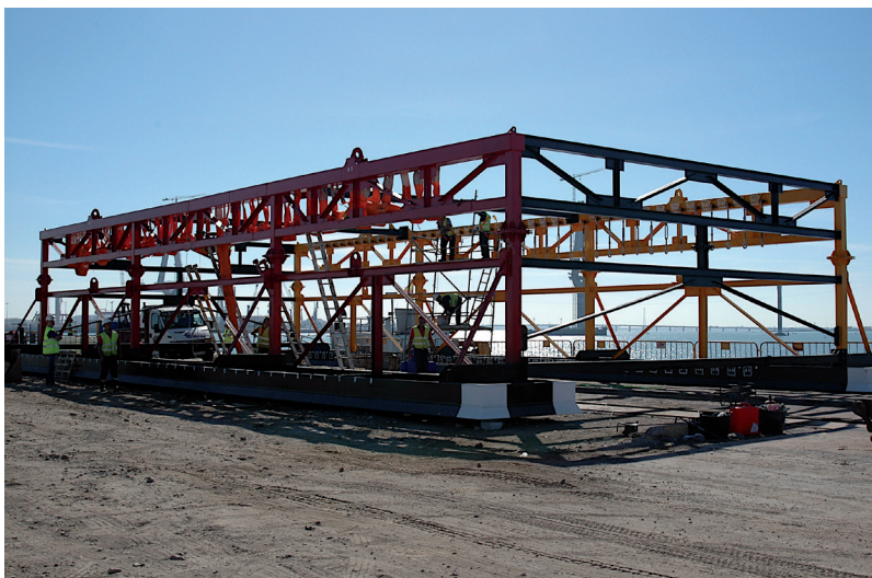
Figura 11. Estructura para el traslado del pecio Delta I . Fotografía: IAPH. Autora: Carmen García.
