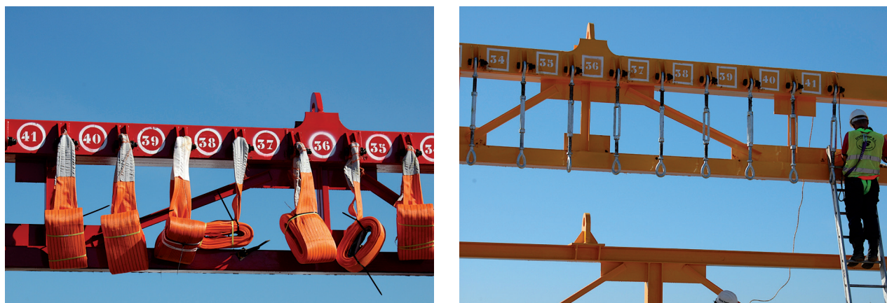
Figura 12. Enganches numerados para colocación de las cinchas.
