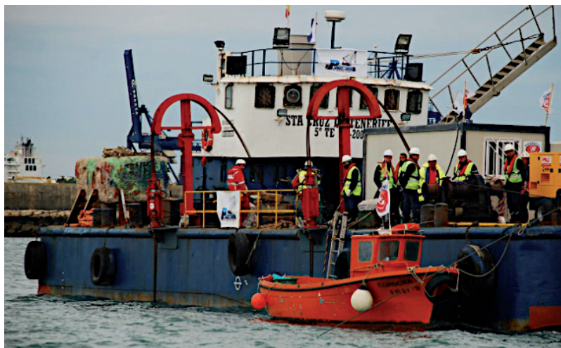
Figura 15. Pontona Santa Cruz de Tenerife. Vista de dos de los gatos hidráulicos.
