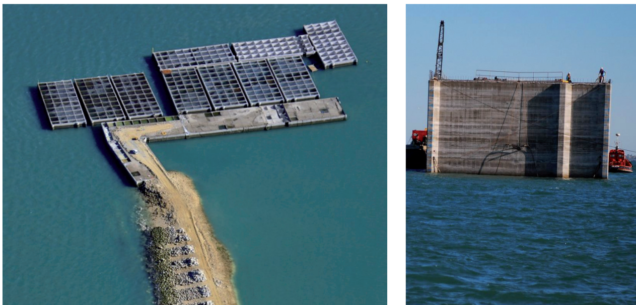
Figura 10. Situación del pecio Delta I y vista lateral de uno de los cajones.
