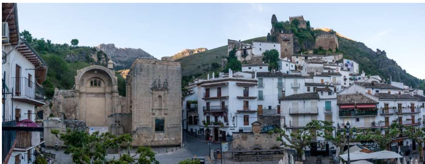
Vista general de la plaza de La Corredera y su entorno, con las ruinas de la iglesia de Santa María (Cazorla, Jaén) | foto Fondo gráfico IAPH (Isabel Dugo Cobacho)
