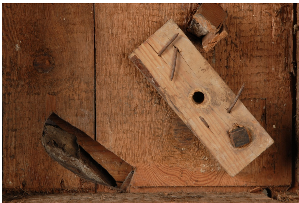
Perno de hierro colocado para la sustentación de la obra después de la caída de la salida procesional de 1967.
