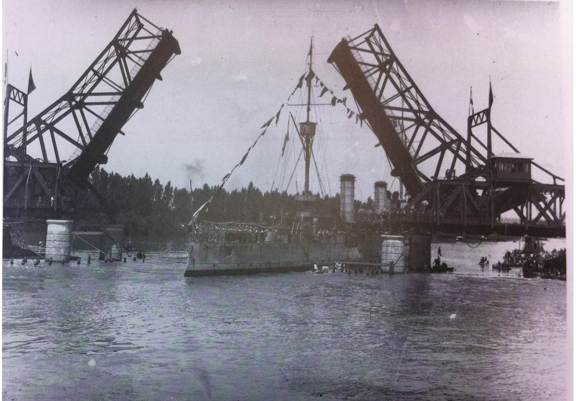
Fotografía de la inauguración del Puente de Alfonso XIII por el crucero argentino " Buenos Aires ". Archivo Serrano. 1926.
