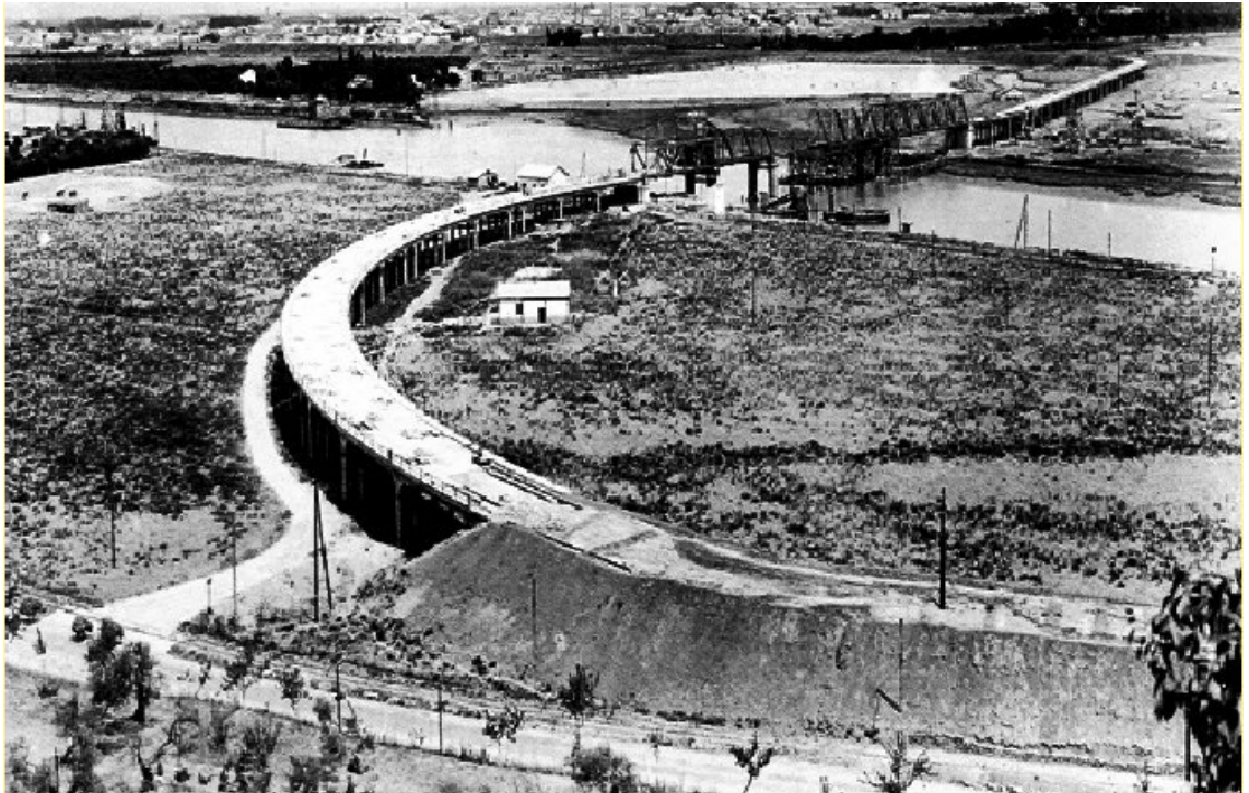
Fotografía de la construcción de la carretera Sevilla-San Juan de Aznalfarache.
