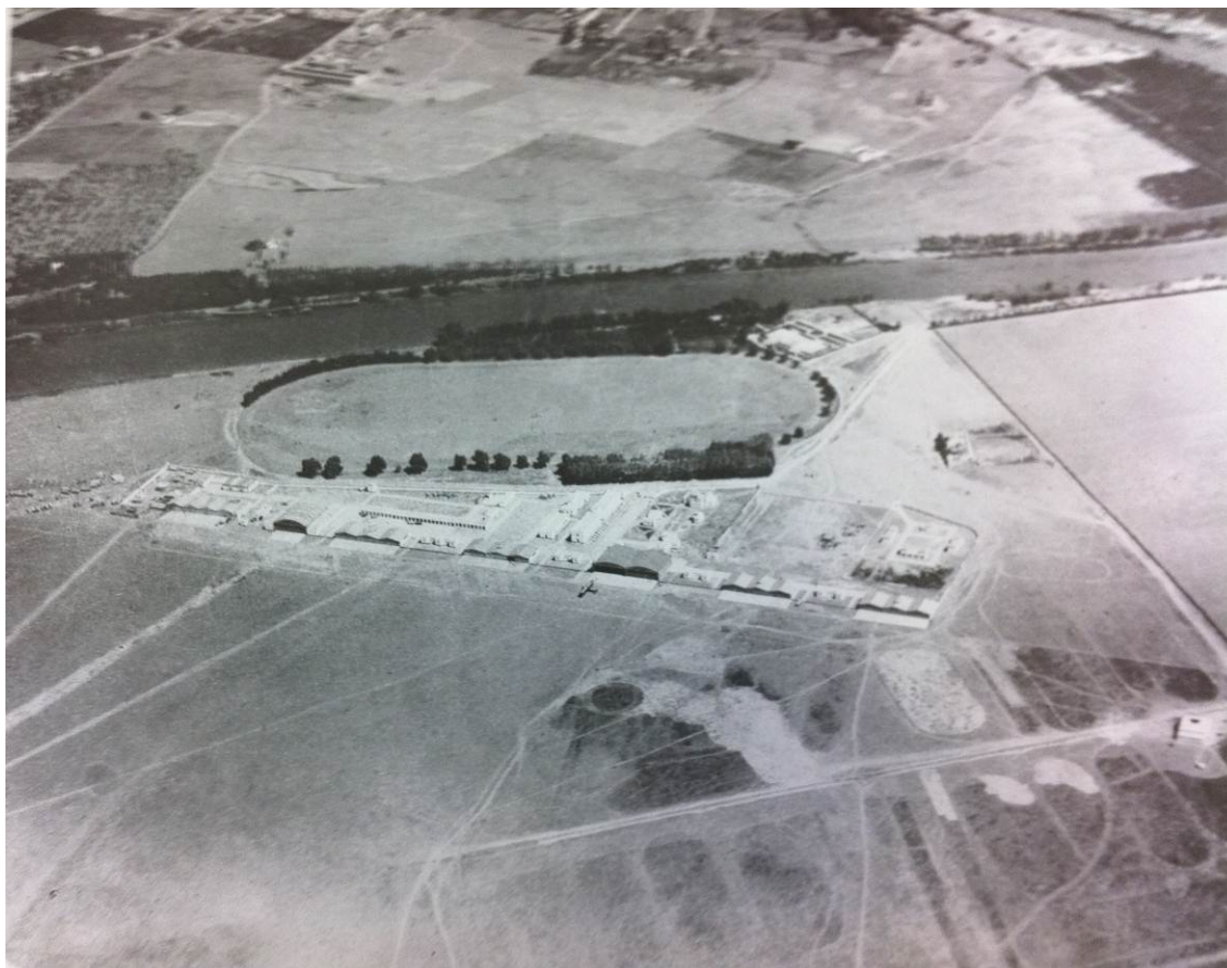
Fotografía aérea de la zona de Tablada. Vista del hipódromo, hangares, naves y demás espacios de ámbito militar. 1922-1929. Ejército del Aire.
