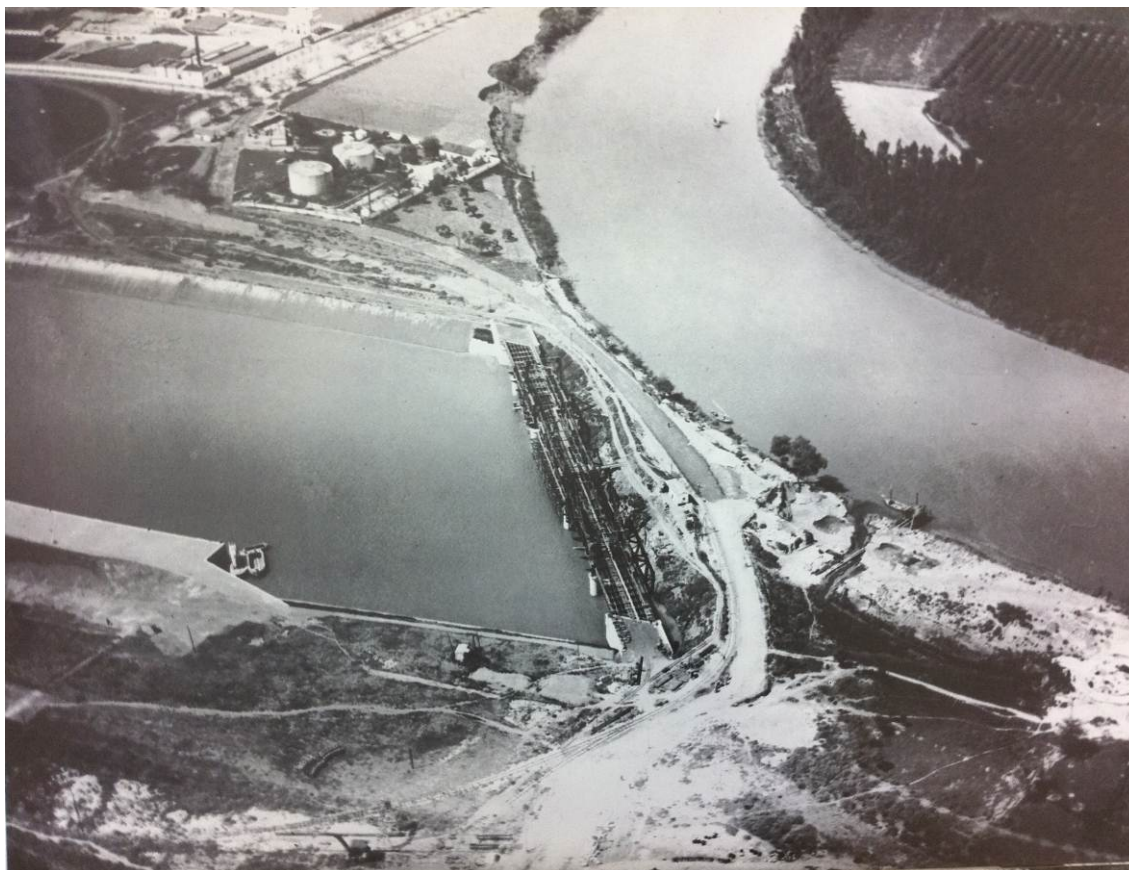
Fotografía de la construcción del puente de Alfonso XIII en la zona de la Corta de Tablada. 2ª Región Aérea, Sevilla. 1925.
