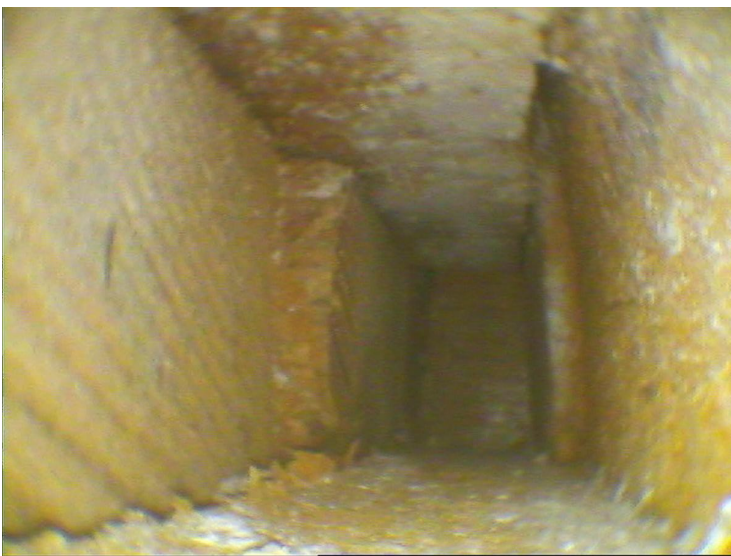
Interior de la obra, imagen tomada con el endoscopio.
