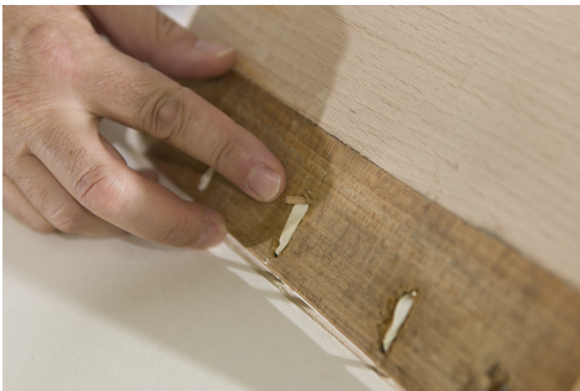
Inserción de espiga para asegurar el anclaje de la costura
