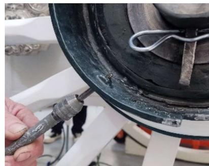
*Tratamiento. Sustitución de la tornillería de las chapas de cerramiento superiores; se eliminaron los tornillos bicromatados -ya afectados en parte por la oxidación- por otros inoxidable, repasando el avellanado del agujero en la chapa para mantener las cabezas enrasadas con la superficie. Igualmente se sustituyeron aquellos casquillos internos de anclaje de piezas de la crestería y pernos de fijación que habían perdido su funcionalidad.*
