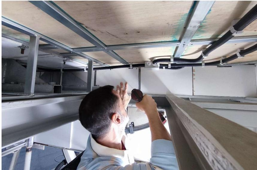
*Tratamiento. Interior del cajón. Cerramiento de los huecos del bastidor de la canastilla; el sistema de fijación reversible de los tableros permite el desmontaje para una inspección o para la sustitución de éstos. Este cerramiento evita la entrada de suciedad y arena desde la canastilla al interior del cajón.*
