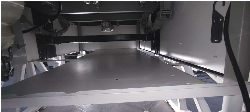
*Tratamiento. Cajón. Estado final del interior con el tablero inferior sin terminar de encajar en su sitio. Se colocó un burlete en el perfil metálico donde encaja el tablero para minimizar la entrada de arena y suciedad.*
