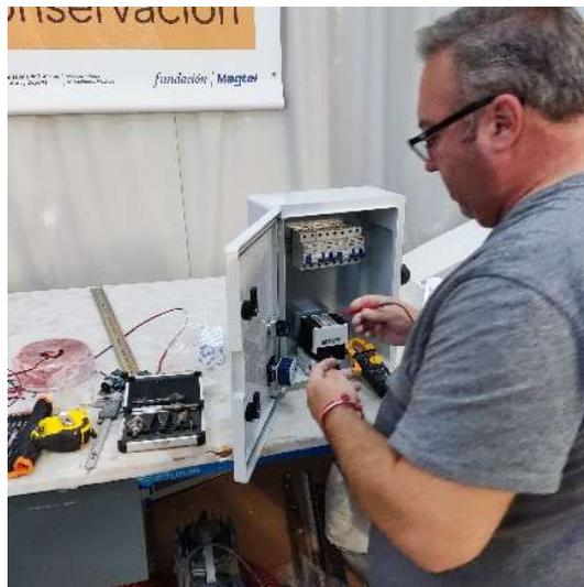
*Tratamiento. Montaje de nuevo cuadro eléctrico; se ha dotado al sistema de tres fases de encendido para seleccionar tres modos: sólo las tulipas superiores de los candelabros; tulipas superiores y plafones del Simpecado y de la Virgen del Rocío; toda la candelaría.*
