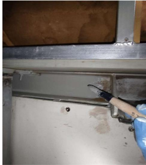
*Tratamiento. Interior del cajón. Cerramiento de agujeros en los tableros del cajón, y posterior enmasillado, lijado y pintado; pintado de las vigas de chasis y estructuras metálicas (patas).*
