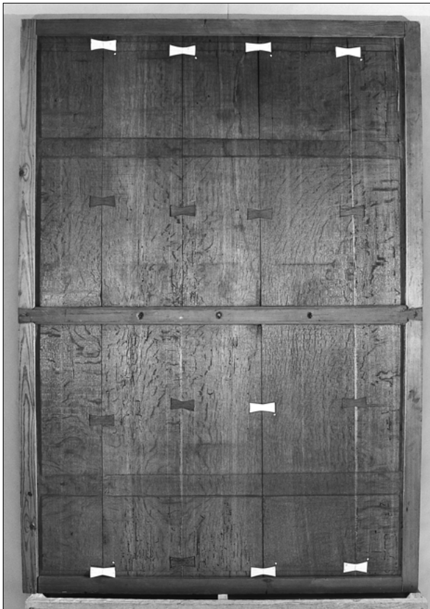
5. Toma general del reverso. Reposición de las colas de milano perdidas.
