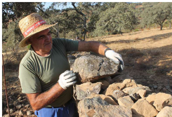
Construcción de muros de piedra seca en Arroyomolinos de León (Huelva)
