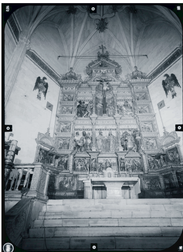
Foto 2. Negativo de 13 x 18 cm. Corresponde a la cámara UMK. Se observan las marcas fiduciales.
