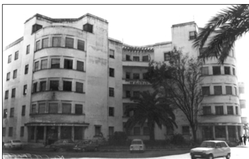
Edificio "El Olivillo". Cádiz. A. Sánchez Esteve. 1938-43. Foto actual y 1975
