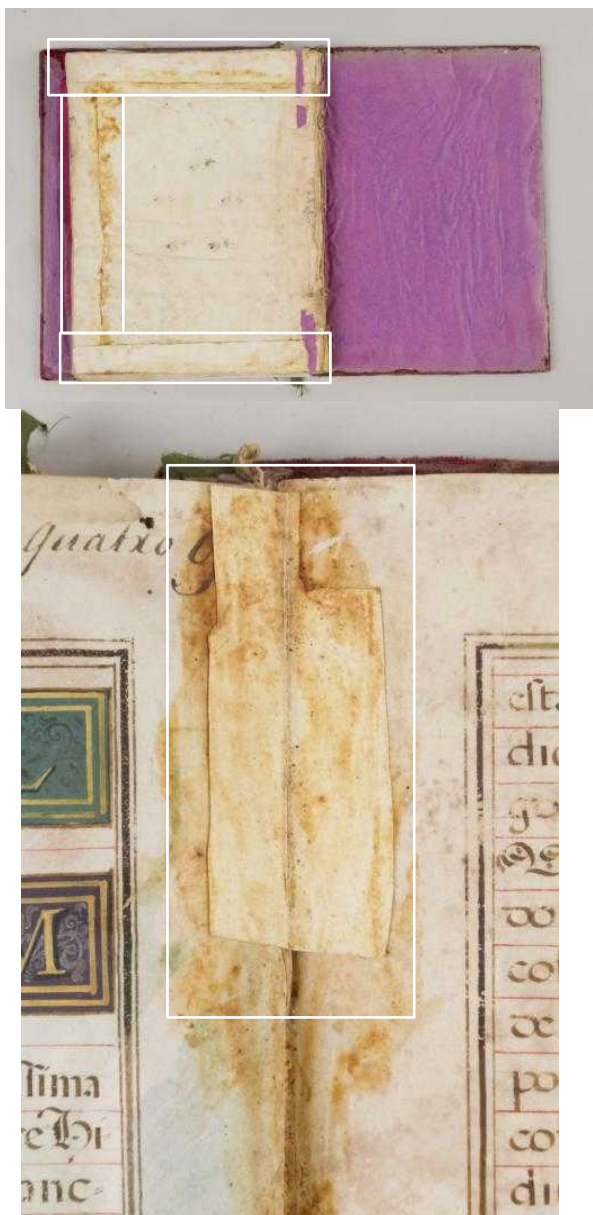
ESTADO DE CONSERVACIÓN. ALTERACIONES. CUERPO DEL LIBRO. Parches procedentes de intervenciones anteriores que provocaron tensiones y deformaciones.
