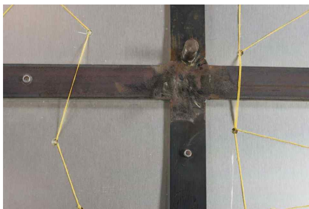
Disposición de los elementos de la formaleta y oxidación de zonas de la cruceta
